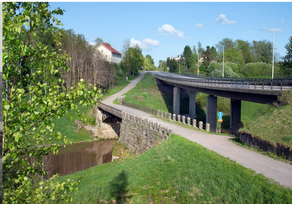
Halikonjoen silta, Salo, Varsinais-Suomi
